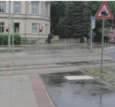
Vor dem Gleisbereich ist in Richtung Norden eine Haltelinie für Radfahrer angeordnet. Der Radfahrer müsste – um keine Ordnungswidrigkeit zu begehen – sein Fahrzeug abstellen, über den Gleisbereich zum Masten gehen, den Knopf betätigen und dann zu seinem Fahrrad zurückgehen!
