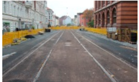
Fast abgeschlossen: Sanierung der Leonhardstraße. Rechts und links sind bereits die neuen Radfahrstreifen zu erkennen.
